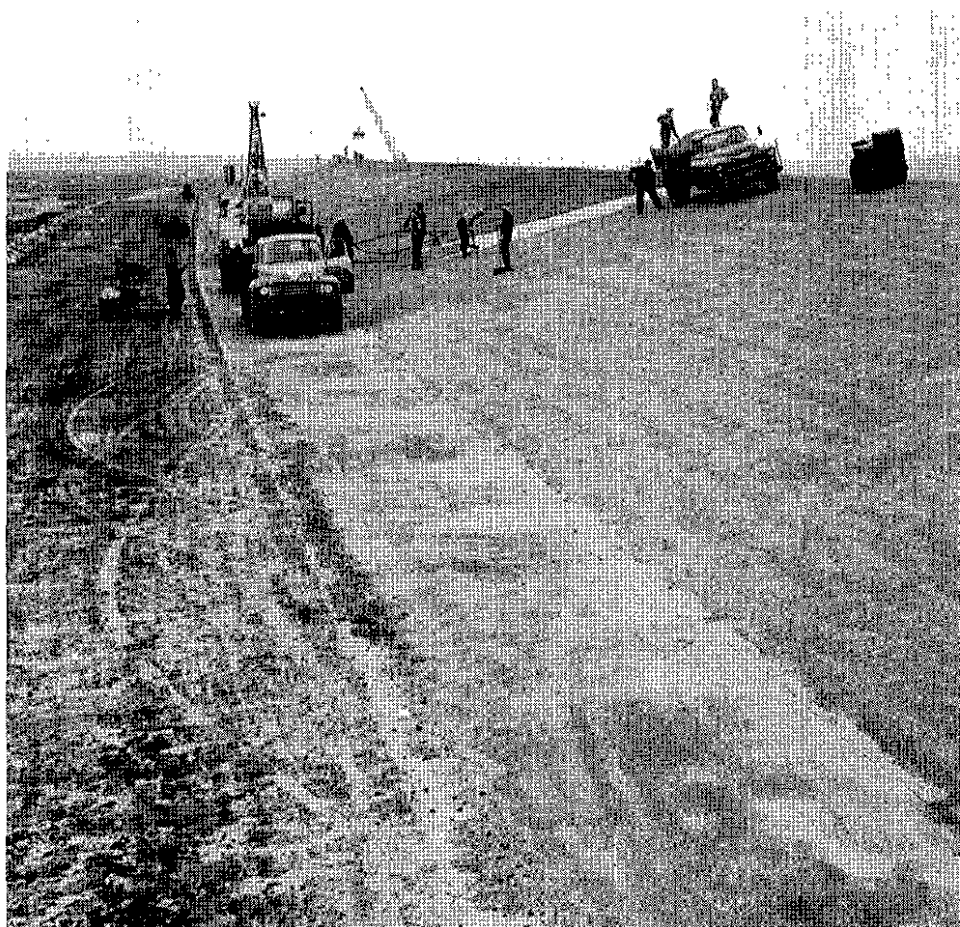
Het aanbrengen van de asfaltbekleding op het buitentalud van de verzwaarde zeedijk van de Banckspolder
